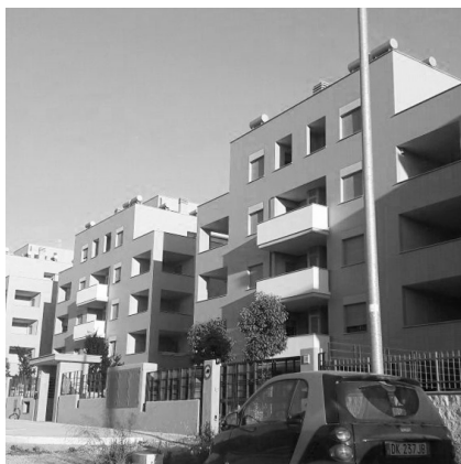
39 alloggi Monte Stallonara
