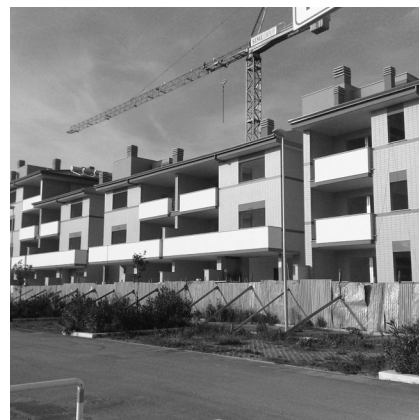
6 alloggi a Palidoro
